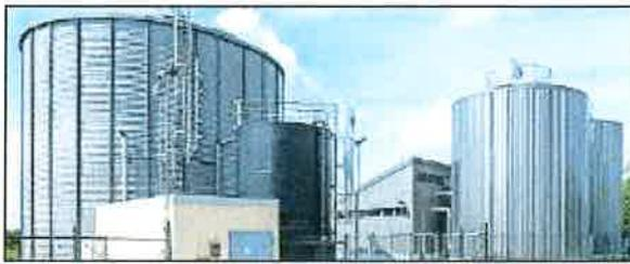
Faultürme der Edenkobener Kläranlage. Sie dienen der Stabilisierung des Klärschlammes und verwandeln dessen organische Bestandteile in Gas. FOTO: WVI
